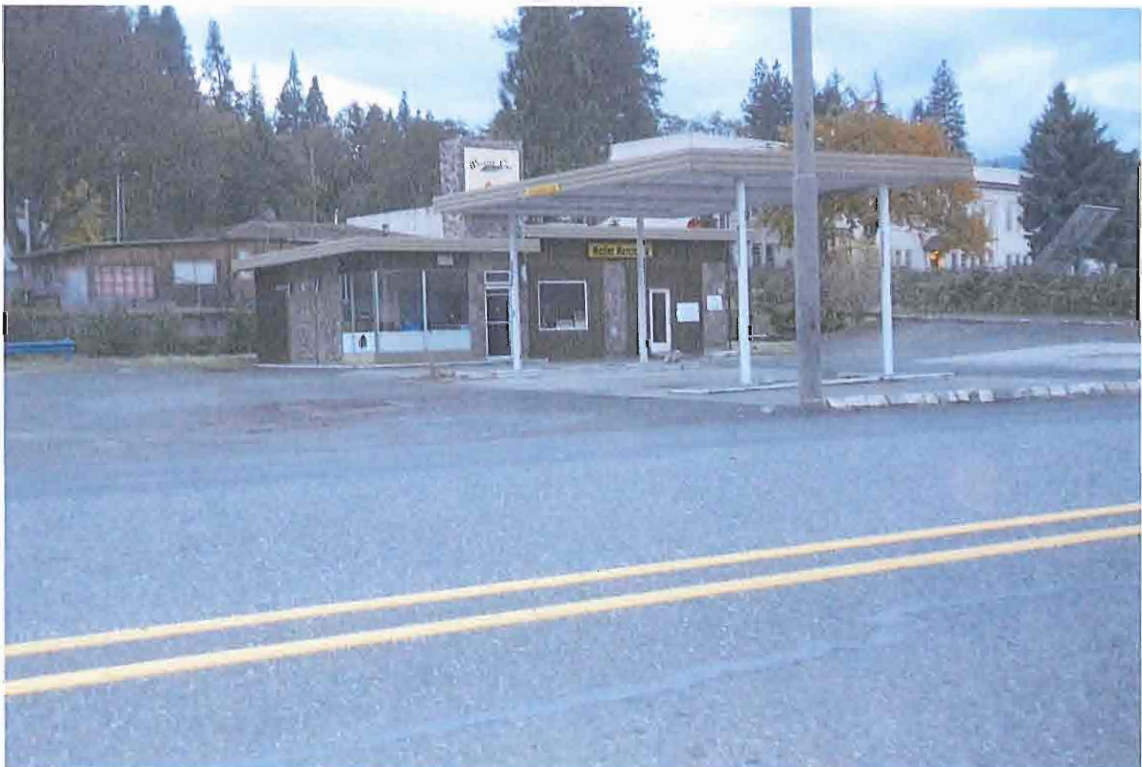
Mosier Gas Site
